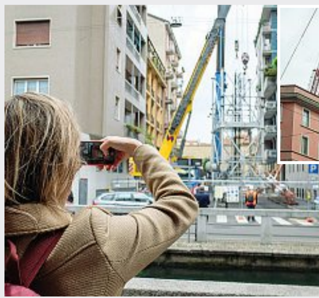
L'operazione Al posto dell'antenna Telecom di via Bettinelli, in zona Darsena, nascerà una residenza per giovani con caffetteria e coworking
