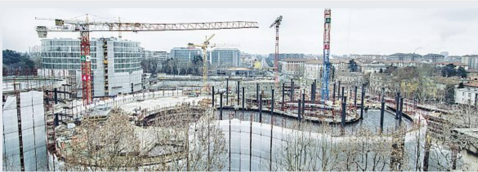
Lavori in corso Il progetto per il nuovo campus della Bocconi è stato realizzato dallo Studio Sanaa delle archistar giapponesi Kazuyo Sejima e Ryue Nishizawa. (Delfino)
