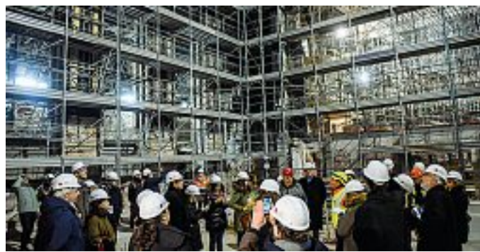
Le impalcature. Una visita al cantiere del teatro Lirico in via Larga a dicembre (Furlan)
