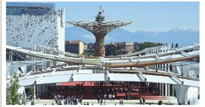
Sito espositivo La «piastra» è l'infrastruttura chiave dell'intero polo
